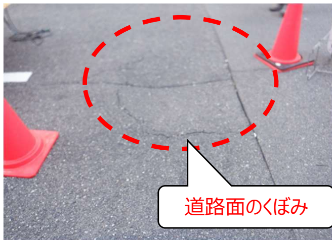
道路面のくぼみ発生状況
