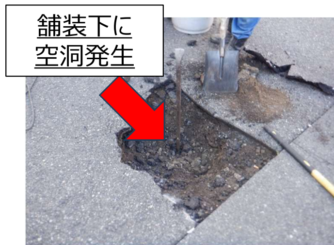
舗装撤去により空洞確認
