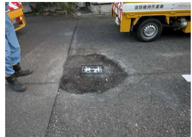
応急処置完了 ※後日、取付管を取替え済
