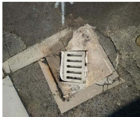
鉄板撤去状況
