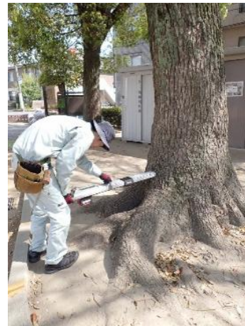
図 機器診断の様子
