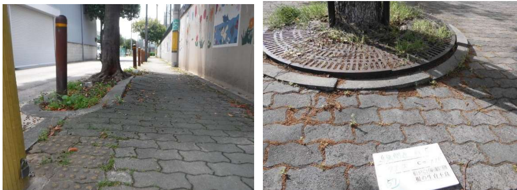
写真 根上りによる舗装の不陸等
