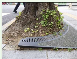
写真 大木化による根上り
