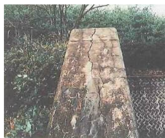
鉄筋方向に沿ったひび割れ
