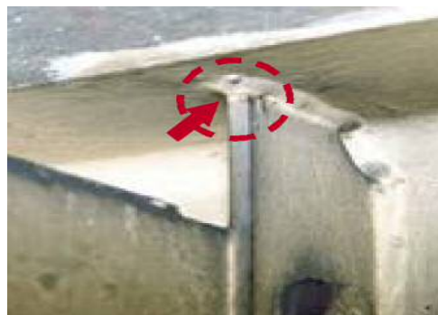
損傷区分「c」 （接合部、塗膜割れ）
