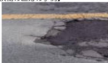
損傷区分「c」 h < 20\text{mm} 、ポットホール W \geq 15\text{cm}
