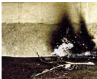
損傷区分「e」 (火災による変色)
