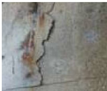
損傷区分「d」 (浮き)
