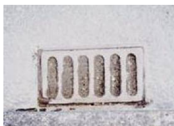
損傷区分「e」 (土砂詰り)
