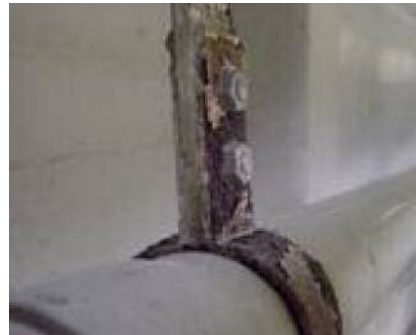
損傷区分「e」 (板厚減少、広範囲腐食)
