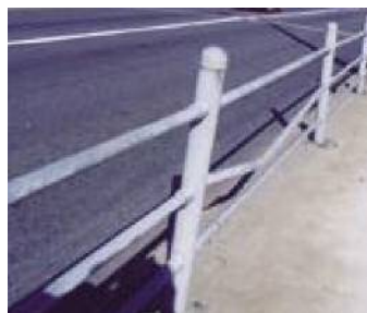
損傷区分「c」 (変形)
