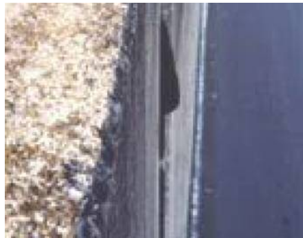
損傷区分「c」 (目地部材のずれ)
