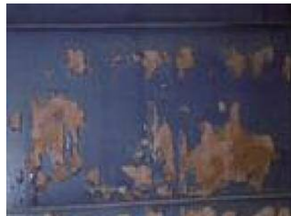
損傷区分「c」 (表面のみ、広範囲腐食)
