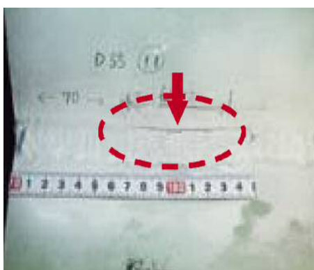
損傷区分「e」 （線状の亀裂）
