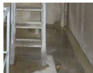
損傷区分「e」 (排水溝から漏出)
