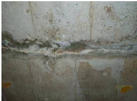
損傷区分「c」 (目地部から漏水)
