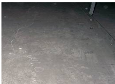
損傷区分「d」 (ひび割れ)
