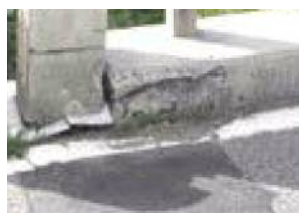
損傷区分「e」 (著しい欠損)
