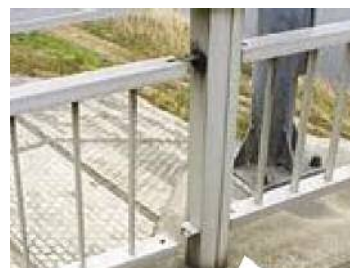
損傷区分「e」 (継手部が破断)
