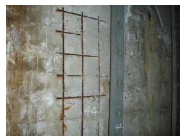
損傷区分「e」 (鉄筋露出、著しい腐食)
