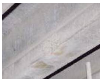
損傷区分「c」 (剥離)
