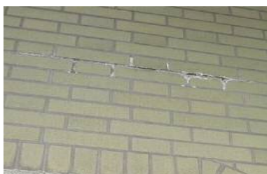
損傷区分「d」 (遊離石灰)
