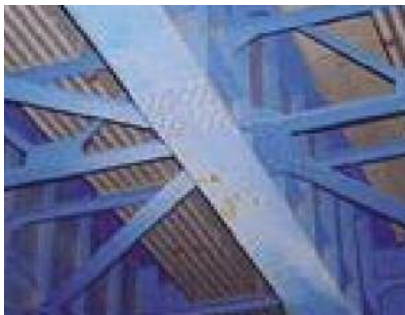
損傷区分「b」 (表面のみ、局部的腐食)
