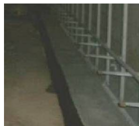
損傷区分「c」 (排水溝の滞水)
