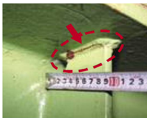
損傷区分「e」 （塗膜割れ、錆）
