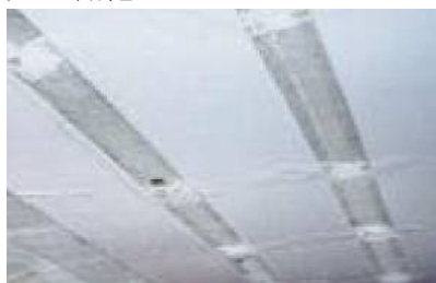
損傷区分「c」 (遊離石灰)
