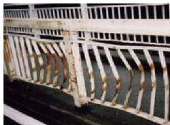
損傷区分「e」 (著しい変形)
