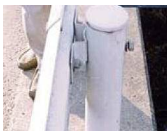
損傷区分「c」 （ゆるみ1本のみ）
