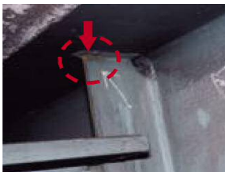
損傷区分「c」 （接合部、短い亀裂）
