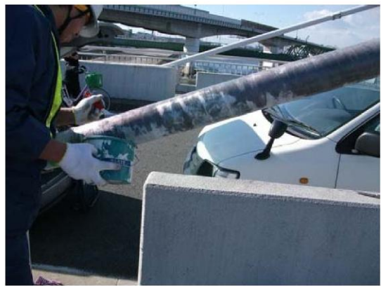
樹脂塗布含浸（FRP下塗り工程完了）
