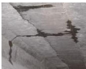
損傷区分「c」 (漏水)
