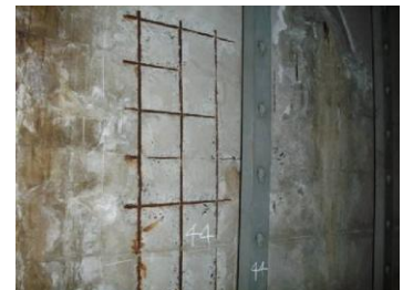
損傷区分「e」 (鉄筋露出、著しい腐食)
