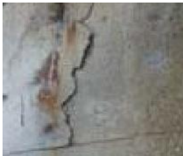
損傷区分「d」 (浮き)
