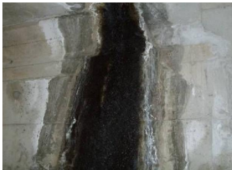
損傷区分「e」 (目地部から著しい漏水)
