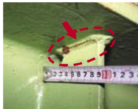
損傷区分「e」 (塗膜割れ、錆)
