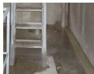
損傷区分「e」 (排水溝から漏出)
