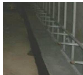
損傷区分「c」 (排水溝の滞水)
