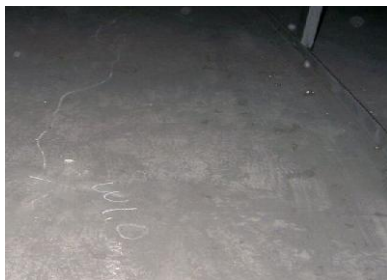
損傷区分「d」 (ひび割れ)
