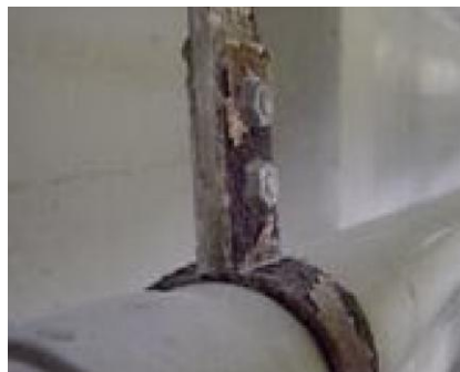
損傷区分「e」 (板厚減少、広範囲腐食)
