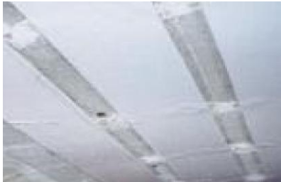
損傷区分「c」 (遊離石灰)
