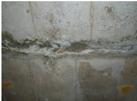
損傷区分「c」 (目地部から漏水)
