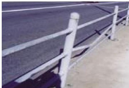
損傷区分「c」 (変形)
