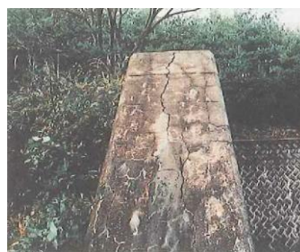
鉄筋方向に沿ったひび割れ
