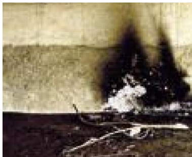
損傷区分「e」 (火災による変色)
