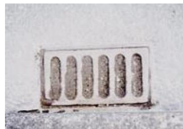
損傷区分「e」 (土砂詰り)
