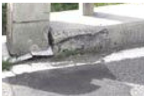
損傷区分「e」 (著しい欠損)
