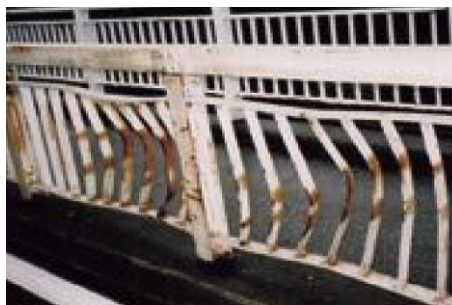
損傷区分「e」 (著しい変形)
