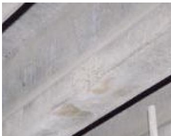
損傷区分「c」 (剥離)
