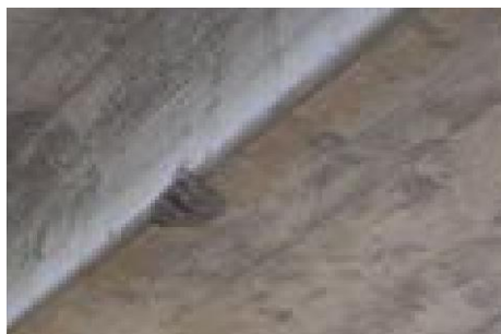
損傷区分「c」 (欠損)
