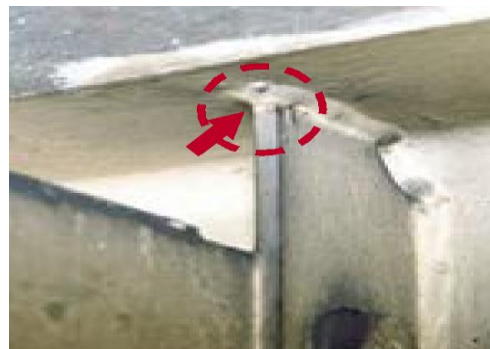
損傷区分「c」 (接合部、塗膜割れ)
