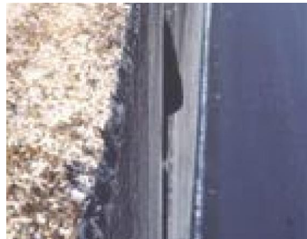
損傷区分「c」 (目地部材のずれ)
