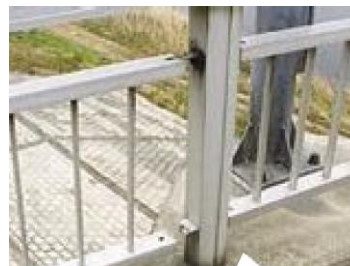
損傷区分「e」 (継手部が破断)
