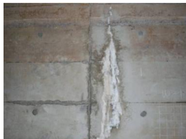
損傷区分「d」 (遊離石灰)
