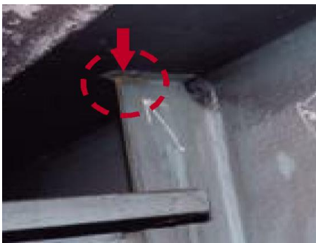
損傷区分「c」 (接合部、短い亀裂)
