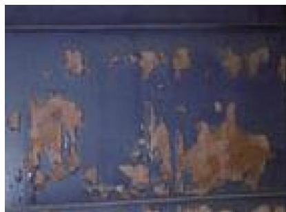
損傷区分「c」 (表面のみ、広範囲腐食)
