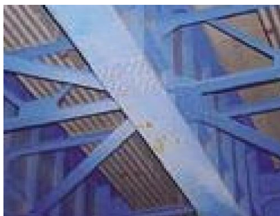
損傷区分「b」 (表面のみ、局部的腐食)
