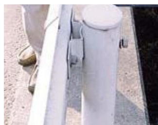
損傷区分「c」 (ゆるみ1本のみ)
