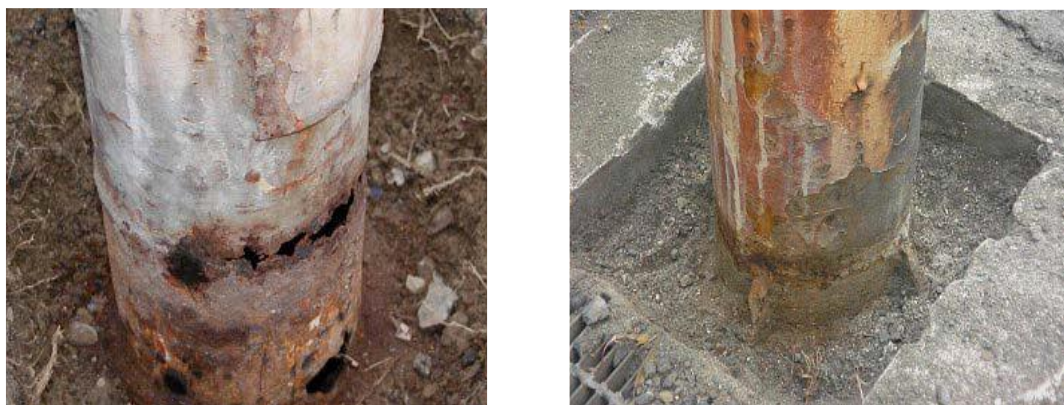
写真-2.2 路面境界部の腐食事例
