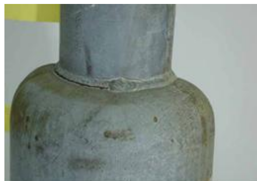
写真-2.1 支柱基部や支柱断面変化部のき裂変状事例
