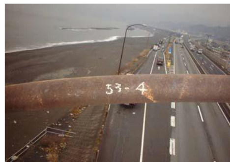
写真-2.4 支柱本体の腐食事例
