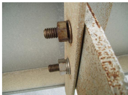
写真-2.3 設置後 10 年以内の付属物の変状事例
