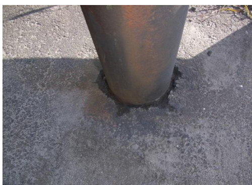
腐食、路面付近での滞水
