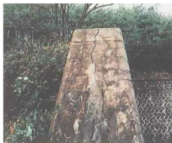
鉄筋方向に沿ったひび割れ
