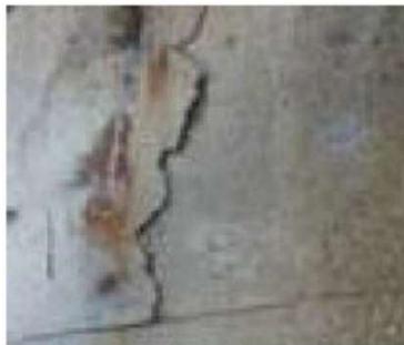
損傷区分「d」 (浮き)
