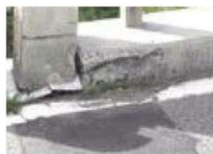
損傷区分「e」 (著しい欠損)
