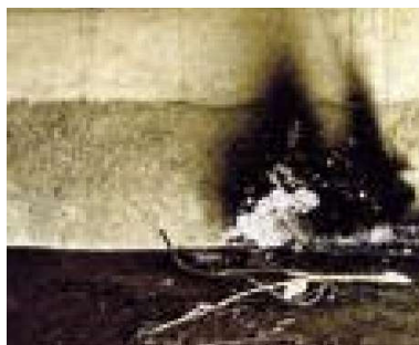
損傷区分「e」 (火災による変色)
