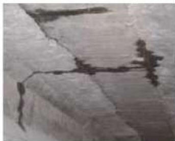
損傷区分「c」 (漏水)
