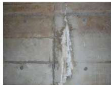
損傷区分「d」 (遊離石灰)
