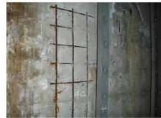
損傷区分「e」 (鉄筋露出、著しい腐食)
