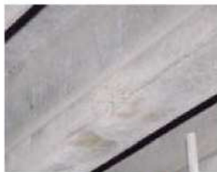
損傷区分「c」 (剥離)
