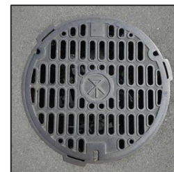
取り替え予定のマンホール蓋
