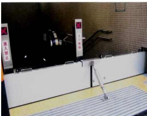
写真11 地下駅出入口の止水板(左：脱着式、右：シート式)
