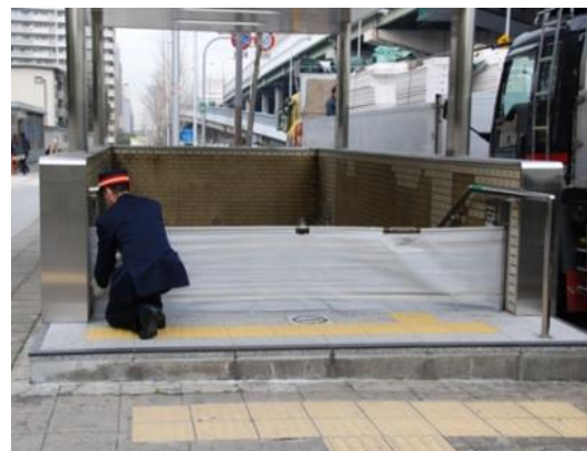
写真11 地下駅出入口の止水板(左：脱着式、右：シート式)
