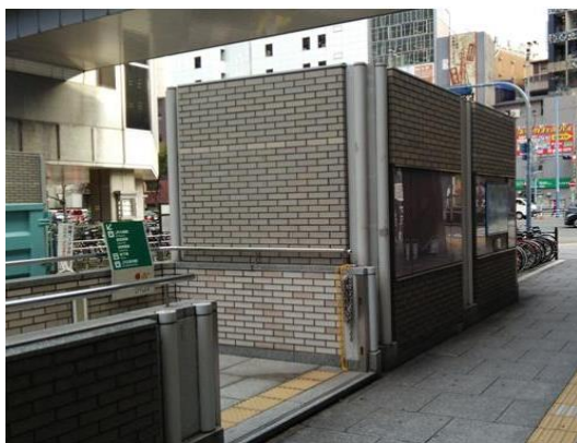
写真6 地下街の換気口 (ディアモール大阪)
