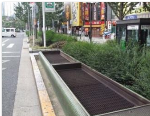
写真7 地下鉄の換気口
