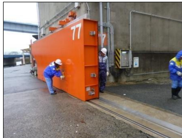
写真 津波防災施設の操作訓練実施状況
