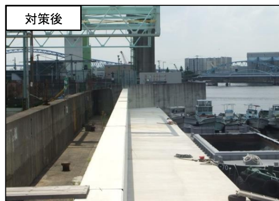
写真 防潮堤の耐震・液状化対策工事
