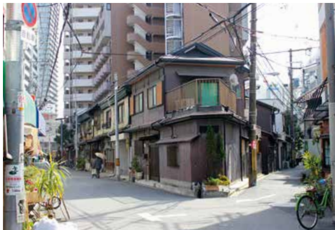
防災対策が求められる レトロな木造建築（北区内） 提供：市民
