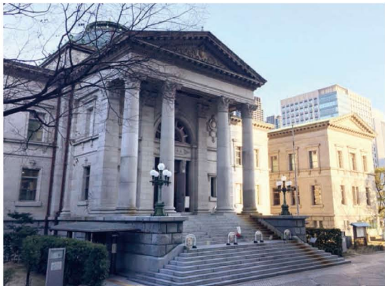
本館と左右両翼が1974(昭和49)年、重要文化財に指定された
