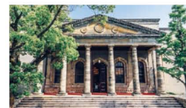
ギリシア建築を思わせる円柱とアーチ窓が特徴的。国指定の重要文化財
