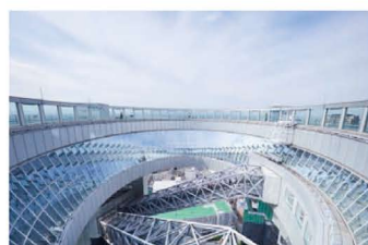
シースルーの空中エスカレーターが大きな穴を通り抜け、40階の「空中庭園展望台」へと続く
