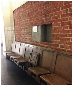
地下1階廊下において自由に座れる「保存椅子」には、座席の裏に帽子を掛ける金具があるものも。ジェントルマン仕様です
