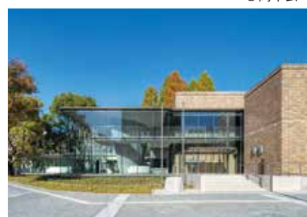
四隅に柱がなく、スタイリッシュなエントランス棟
