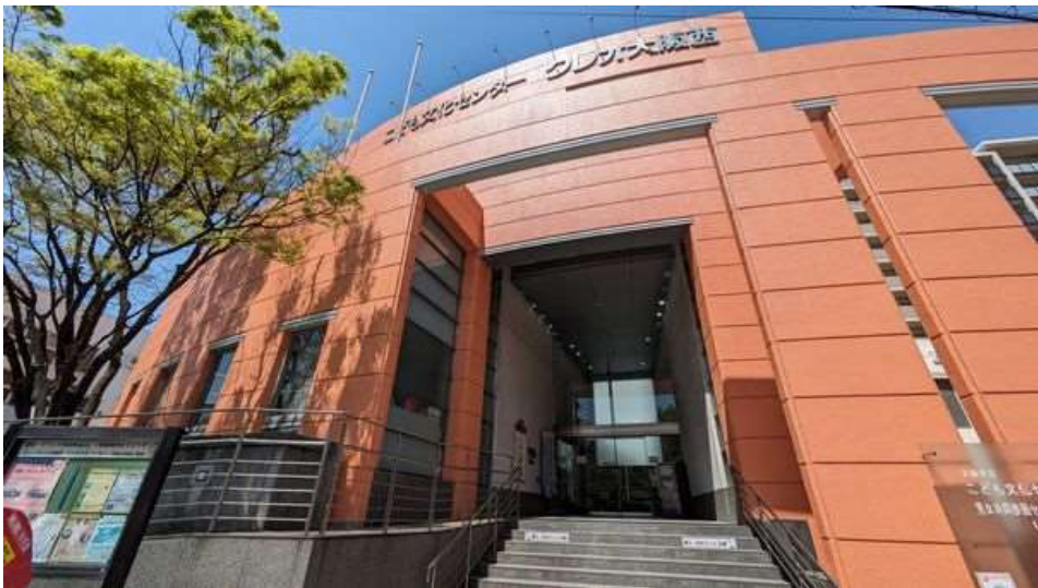
令和 6 年 3 月 外壁等改修工事が完了し、竣工時(平成 6 年)の色合いが戻る
