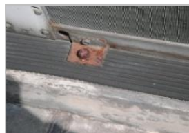
室外機金属部分
