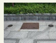
水道メーターボックス (親メーター)
