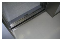
エレベーター扉の敷居溝
