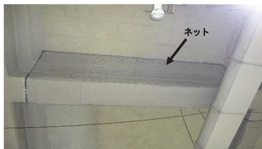
図表－2 落下防止ネットの設置状況及び詳細図
