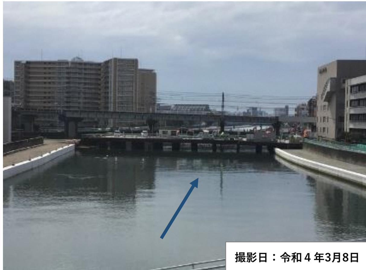
※工事用の仮設工の柱は、令和5年度中に干潮時でも見えなくなるように切断して撤去する予定です。
