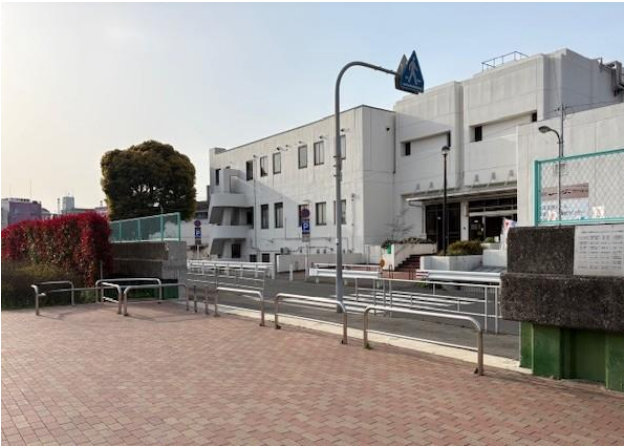
● 既開設区域のパラペット開口部
