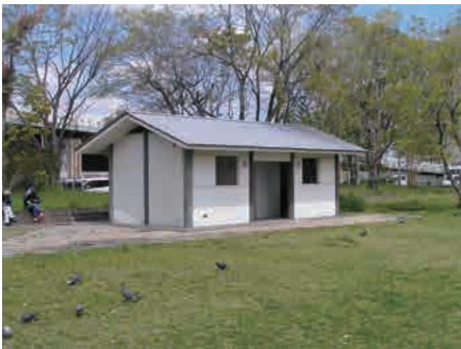
図40 南部ブロックに設置された便所
