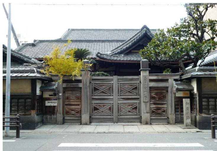
愛珠幼稚園園舎
