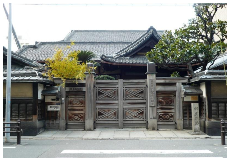
愛珠幼稚園園舎
