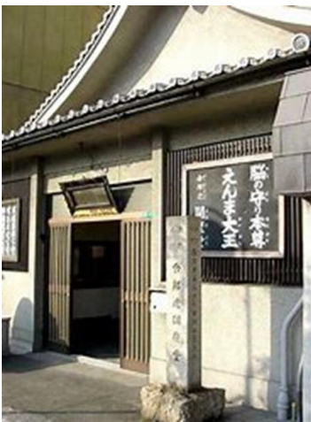
合邦辻閻魔堂正面外観
