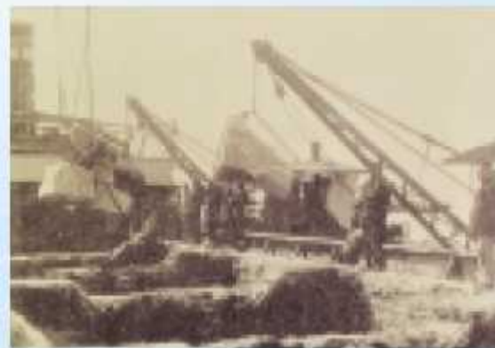
犬島丸から運びあげられる大割石 〔大阪築港100年 上巻〕より
