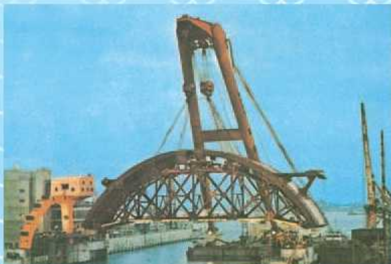
安治川水門のアーチ部架設工事のようす
