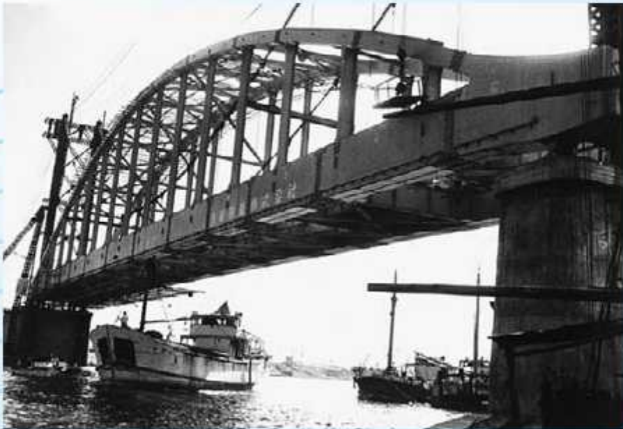
建設中の大阪環状線安治川橋梁(昭和35年)
