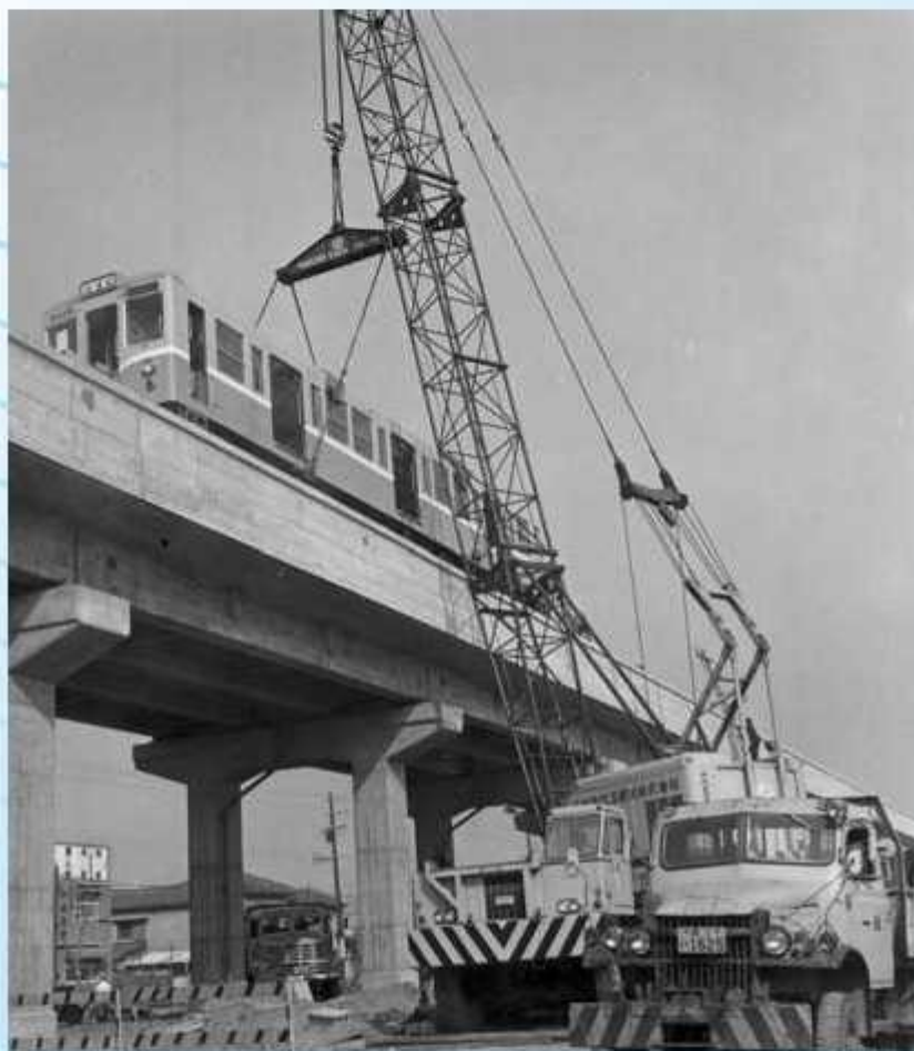
車両のつり上げ クレーンカーによりつり上げられ、車両が搬入されました。
