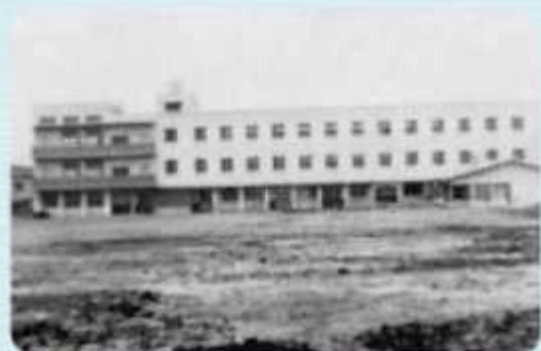
建設中の1号館(昭和35〔1960〕年) 「「港晴」10周年記念誌」より
