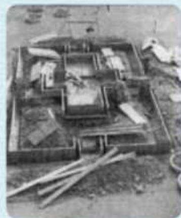
工事中の十字池
