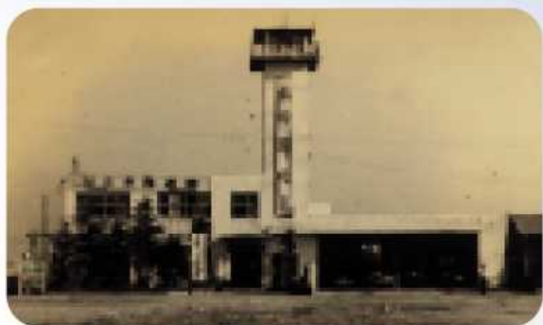
昭和27年にできた鉄筋庁舎(水上消防署提供)
