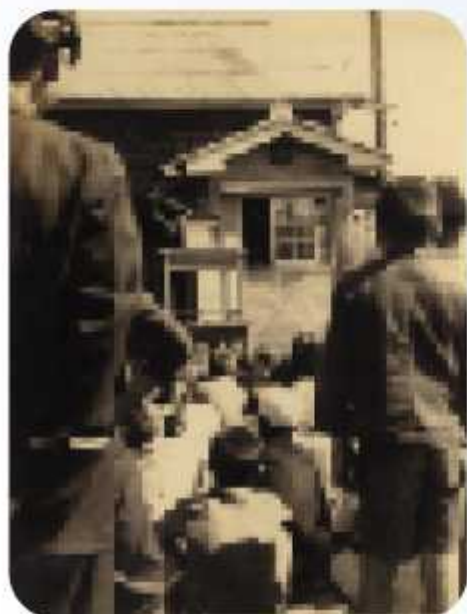
木造庁舎(水上消防署提供)
