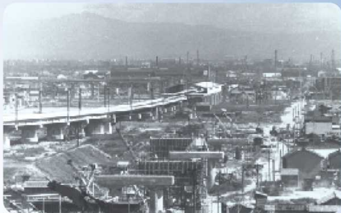
建設中の大阪環状線と弁天町駅、手前は国道43号の橋脚(昭和35年頃)
