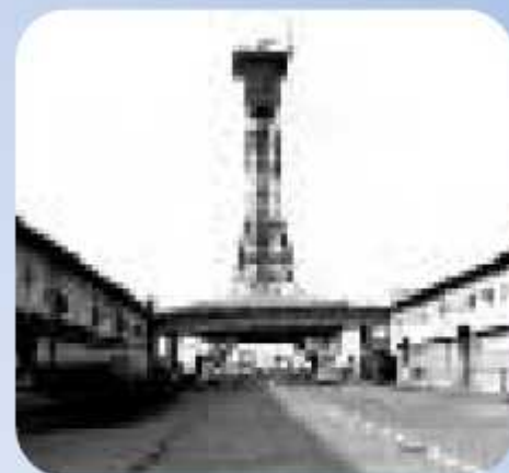
竣工当時のハーバーレーダー (昭和39年)
