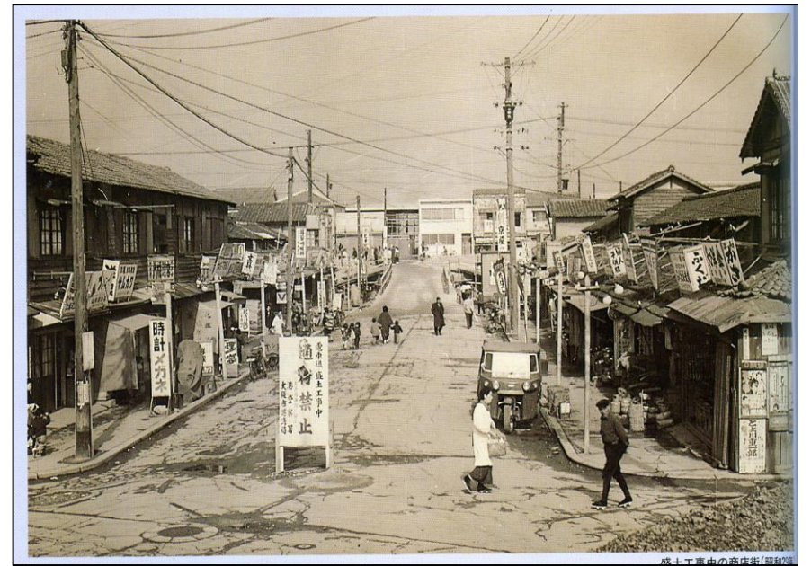
昭和29年 盛土工事中の商店街
