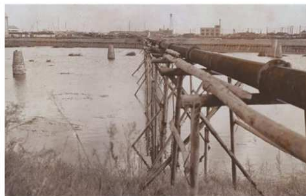
盛土後の路面高に合わせた 下水道マンホールの築造
