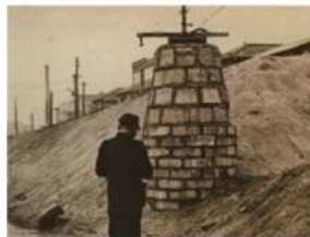
盛土後の路面高に合わせた 下水道マンホールの築造
