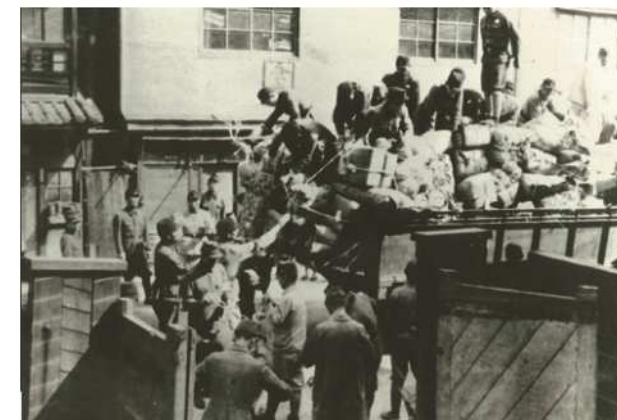
三先小の疎開の荷物の運び出し
