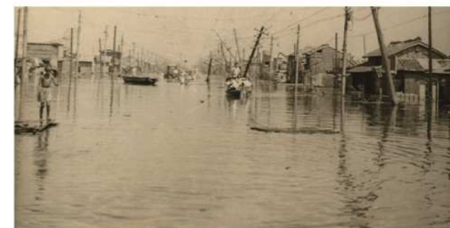
ジェーン台風による高潮浸水（八幡屋付近）
