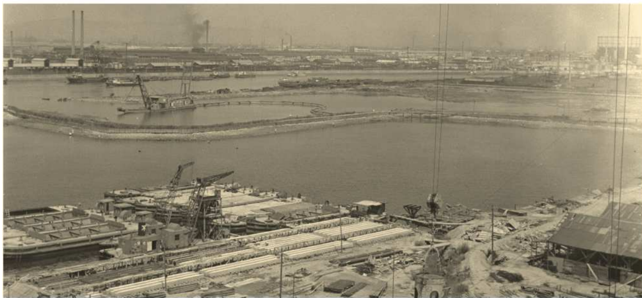
工事中の安治川内港:1954(昭和29)年
