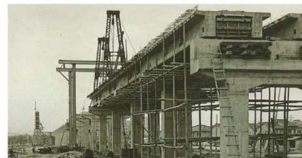
工事中の築港深江線と地下鉄中央線の高架:1960(昭和35)年
