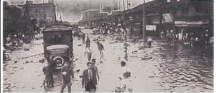
高潮による境川地区の水害
