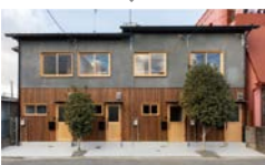
改修イメージ(改修前→改修後)
