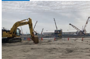
建築工事の様子
