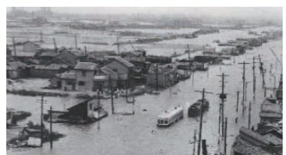
1950(昭和25)年ジェーン台風による高潮被害(千舟橋付近)
