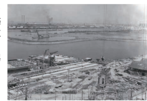
1954(昭和29)年 工事中の安治川内港
