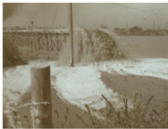
土砂を送り盛土する様子
