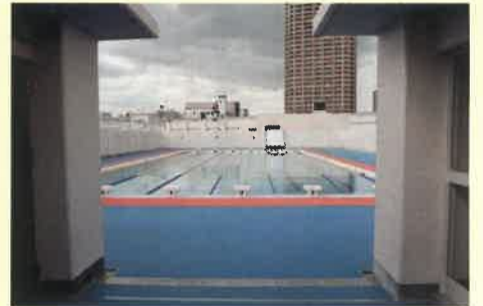
▲講堂屋上 プール
