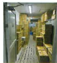
講堂2階にある備蓄倉庫
