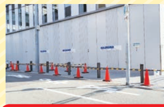
建物西側1階の臨時駐輪スペース
